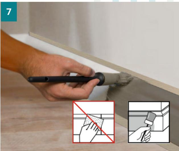
Todos los zoclos de Multiproductos GD ya están recubiertos con una imprimación blanca, pero aún así es necesario repintarlos con una pintura vinílica adecuada base agua (una vez secado el adhesivo, resanador y sellador).
