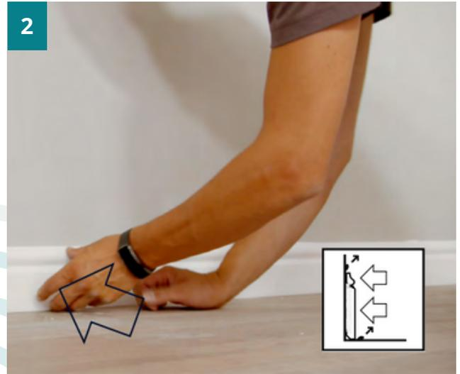
Empuja firmemente, asegúrate de aplicar el borde marcado a la pared. Coloca la moldura en su sitio, comprobando que está horizontal y simétrica a la pared y piso. Cuando estés seguro de que la moldura está colocada correctamente, apriétala firmemente contra la pared y el borde del piso en toda su longitud.
