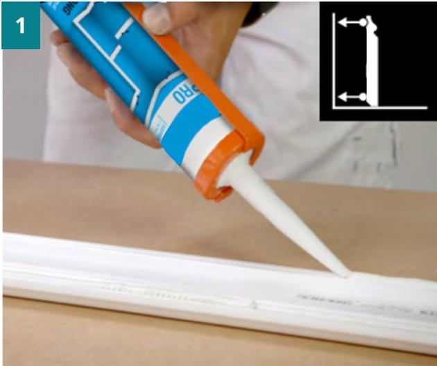
Con ayuda de una pistola de calafateo, aplica adhesivo de montaje en forma de puntos a lo largo de la moldura, ten en cuenta el diseño trasero del tipo de moldura, ya sea que tenga dos espacios resaltados para el pegado a pared y en el caso de las molduras rectas agrega adhesivo en una tercera sección media que estas tendrán.
